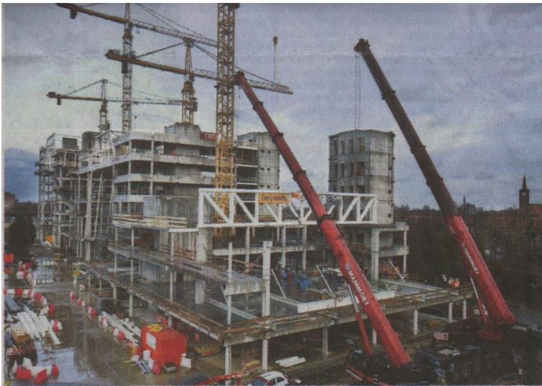
Het nieuwe ROC aan de Lammenschansweg in aanbouw.
